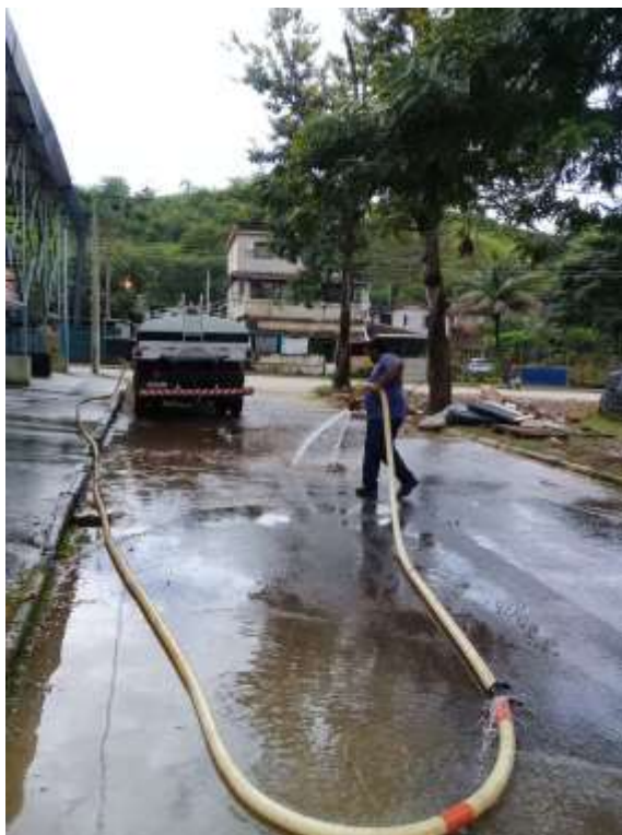
Figura 14 – Serviço de limpeza vias sendo executada no trecho Roseira.
